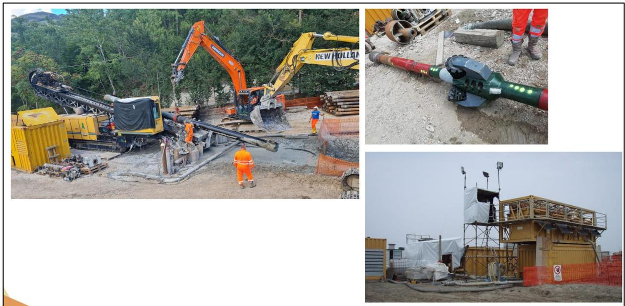
**Figura 14: Porzioni del cantiere di monte con Rig principale e Impianto di pulizia fanghi**
