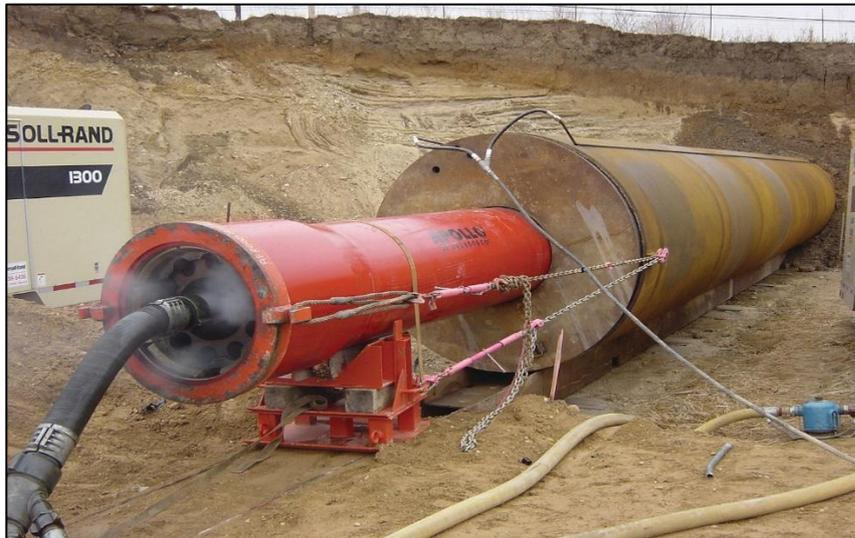
**Figura 11: Sistema Hammerhead per infissione del tubo in acciaio**
